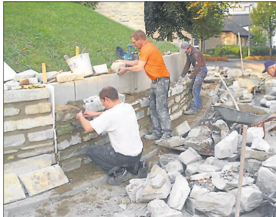
Die Mühlenfreunde aus Ennigerloh haben die Betonsteine an der Ostseite der Windmühle mit einer Natursteinmauer verkleidet.
