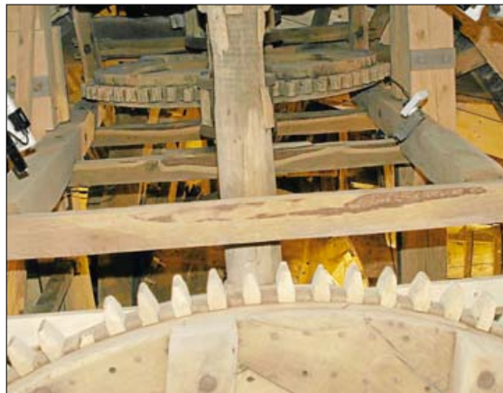
Die Getriebetechnik in der Kappe der Ennigerloher Mühle bietet Besuchern einen imposanten Anblick. Bilder: Rautenstrauch
