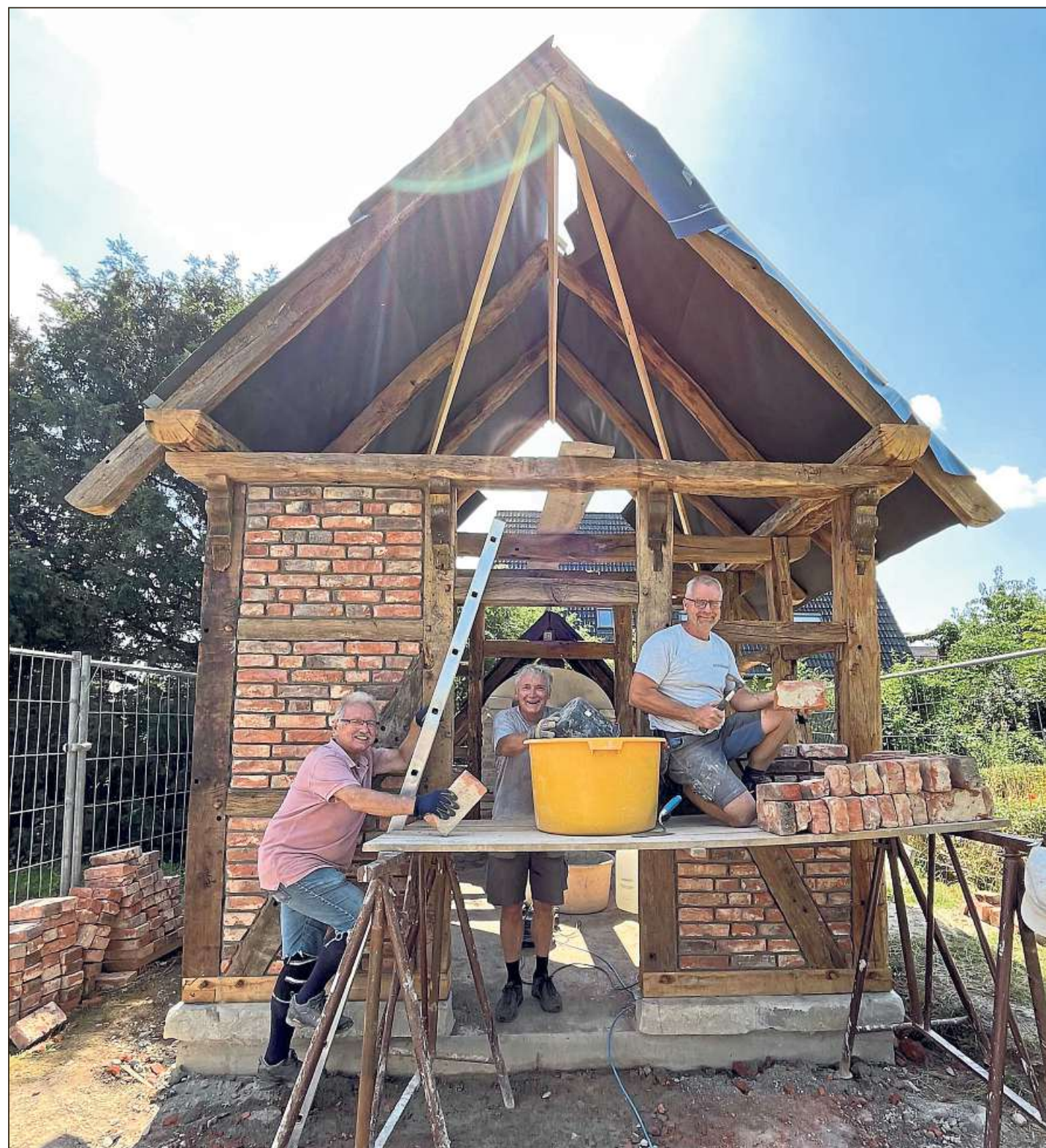
An der Ennigerloher Windmühle errichten die Mühlenfreunde derzeit ein Backhaus in historischer Bauweise. Dabei orientieren sie sich an einem Ennigerloher Vorbild: einem alten Fachwerk-Backhaus aus der Bauerschaft Hoest. Das Bild zeigt (v. l.) Klaus Schmitt, Jürgen Hoss und Heiner Aufderheide. Fotos: Junker
