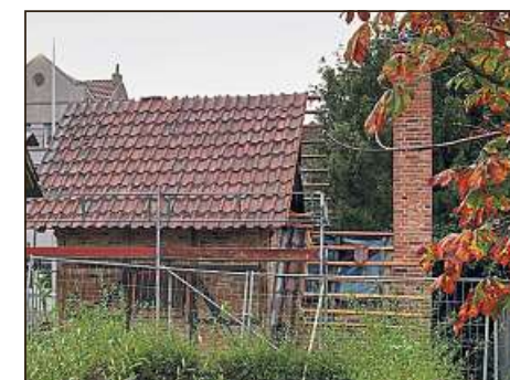
Ende des Jahres soll das Backhaus an der Ennigerloher Windmühle fertiggestellt sein.
