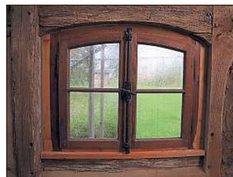
Alte Holzfenster , die aufwändig restauriert worden sind, wurden im Backhaus eingebaut.
