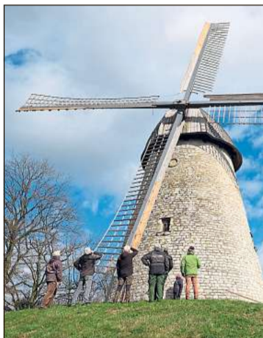
Beim Probelauf der Mühle wurde festgestellt, dass ein Flügel nachverkeilt werden muss.
