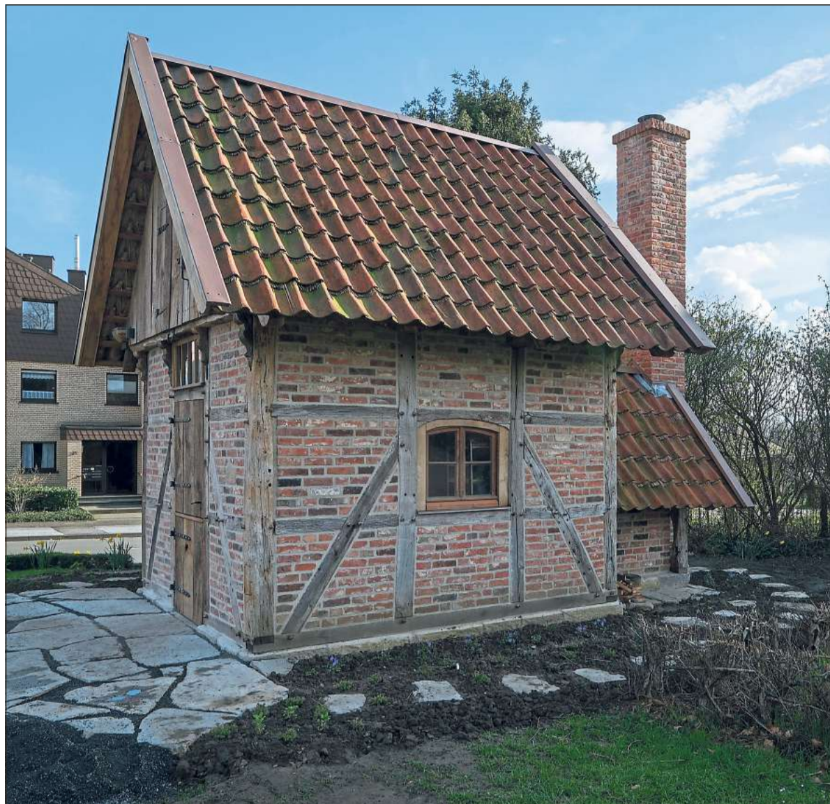
Klein, aber fein: Das Backhaus auf dem Mühlenanger an der Windmühle in Ennigerloh ist fertiggestellt. Am Wochenende wurden die ersten Brote im Holzbackofen gebacken. Fotos: Schomakers
