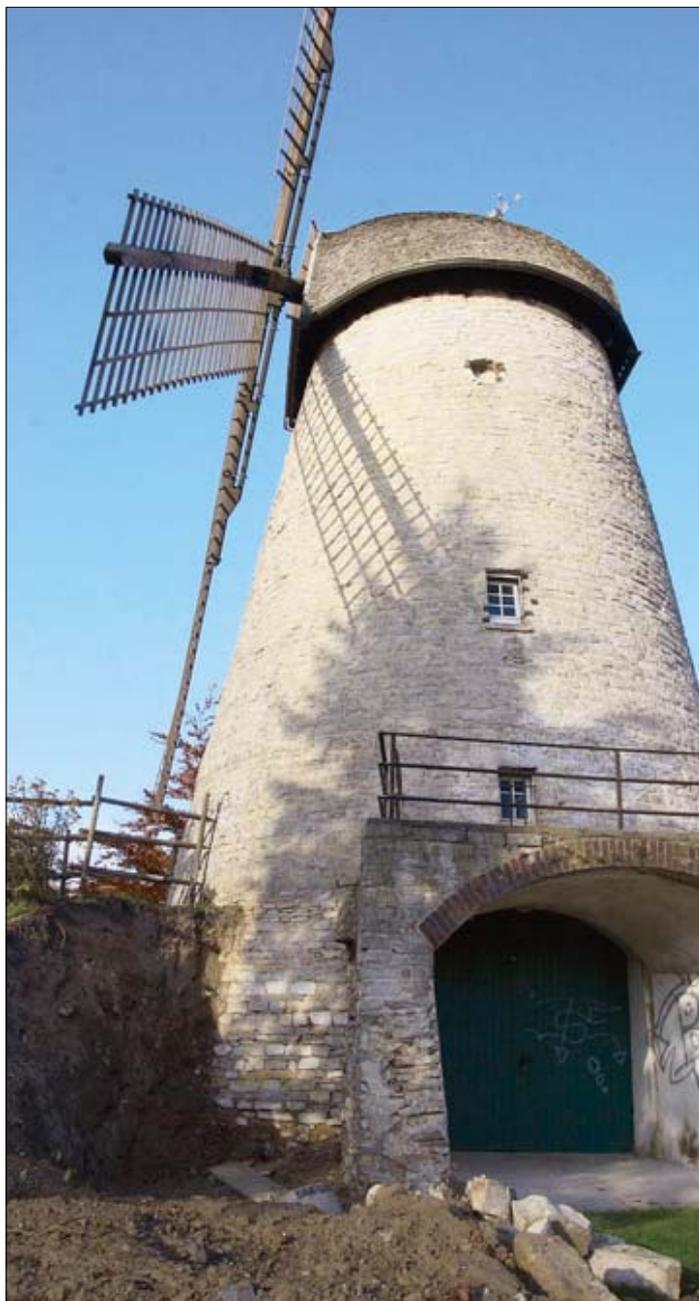
Den Ringerdwall der Ennigerloher Windmühle haben die Mühlenfreunde an mehreren Stellen abgetragen. Später soll das Mauerwerk in diesem Bereich gegen Feuchtigkeit gesichert werden. Bild: dis
