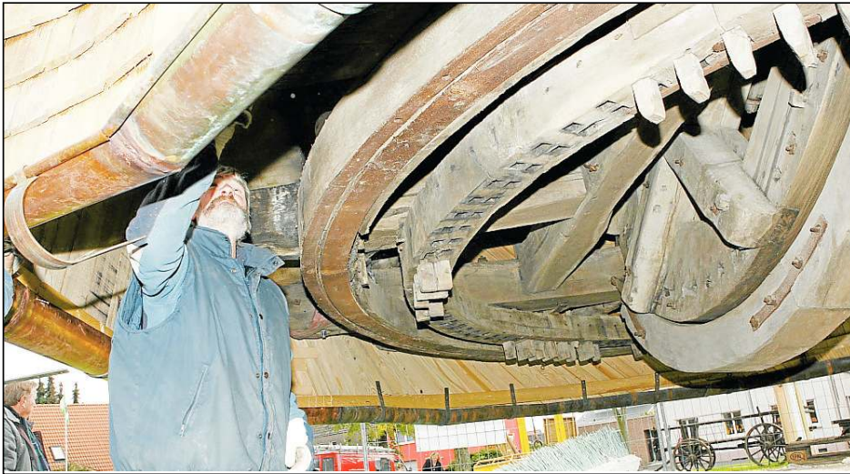
Mühlenbauer Axel Brüggemann legt letzte Hand an, um die 13 Tonnen schwere Kappe auf die Mühle zu setzen. Weitere Fotos sind im Internet in der Bildergalerie unter www.die-glocke.de zu sehen.
