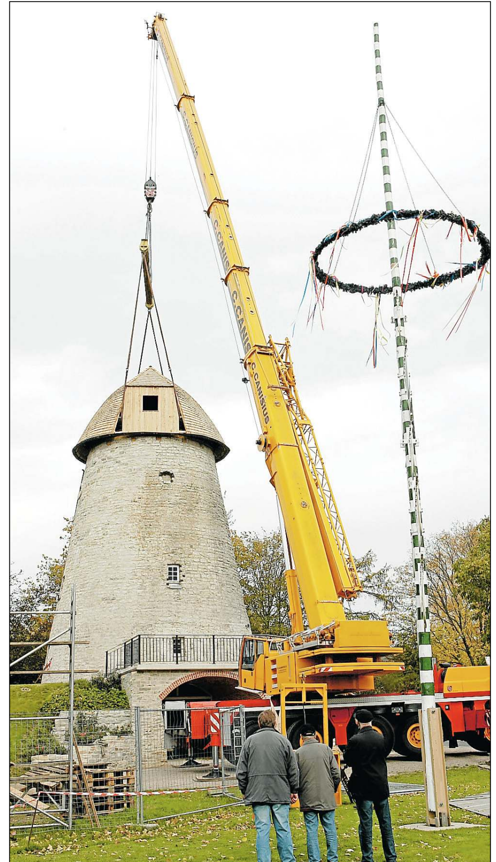
Seit Dienstag hat die Ennigerloher Windmühle wieder eine Kappe. Vier Monate hat die Restaurierung der Mühlenhaube gedauert.
