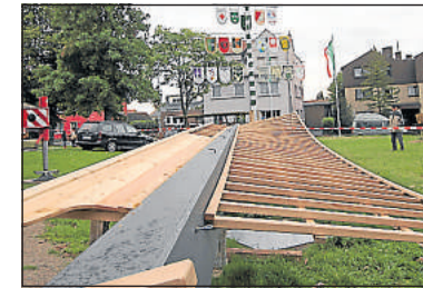
Die Flügelruten aus Stahl waren bereits vor ein paar Tagen vormontiert worden.
