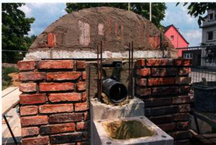
Der Schornstein muss noch aufgemauert werden
