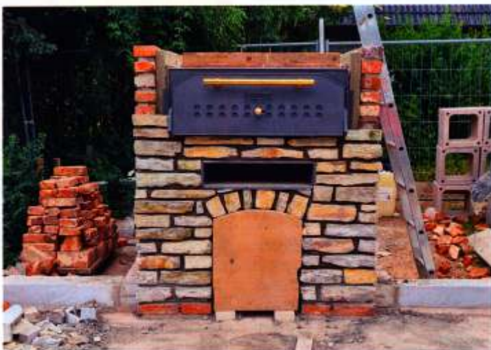
Nimmt Gestalt an: Der Steinbackofen mit gusseiserner Klappe inmitten der Kalksteinfront
