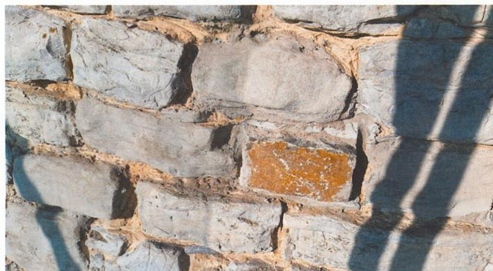
Sanierungsarbeiten im Detail: Im Mauerwerk der Windmühle mussten zerstörte Steine ersetzt (unten rechts) und teilgeschädigte Steine mit Vorschlammungen gesichert werden (Mitte)
