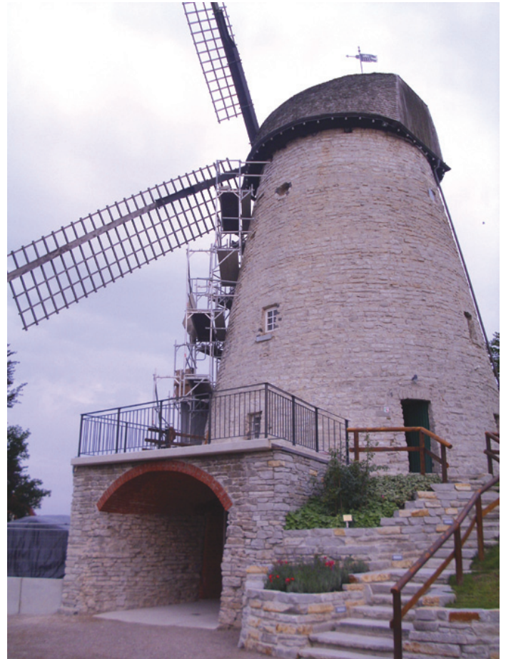
Die Sanierung der Windmühle auf der Wetterseite schreitet voran
