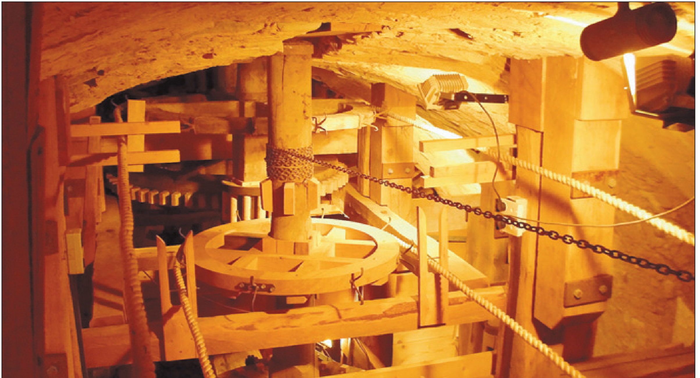
Blick in die sanierte Mahltechnik. Sie wartet noch auf den ersten Einsatz unter Wind.
