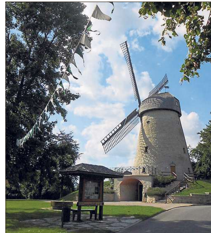
Nach dem Feuer Ende Juli muss die Ennigerloher Windmühle gereinigt und saniert werden.
