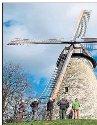
Beim Probelauf der Mühle wurde festgestellt, dass ein Flügel nachverkeilt werden muss.
